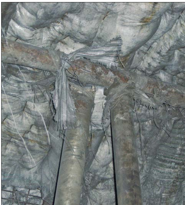
Fot. 2. Profilaktyka przeciwpożarowa (doszczelnienie górotworu)
