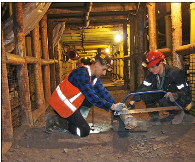
Fot. 7. Obudowa drewniana
