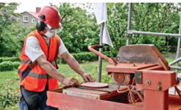
Fot. 16. Środki ochrony oczu oznaczone literą B są odpowiednie przy cięciu dachówek.
