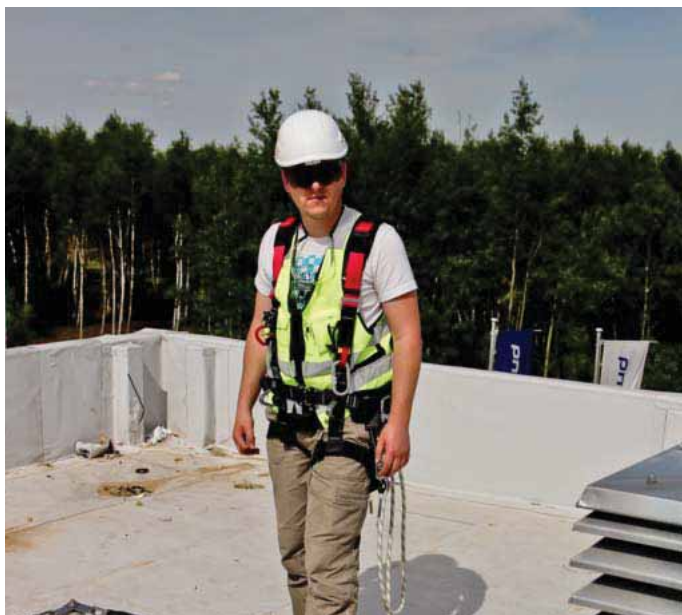
Fot. 14. Praca na otwartej przestrzeni wymaga stosowania środków ochrony oczu o odporności przed uderzeniami w ekstremalnych temperaturach.
