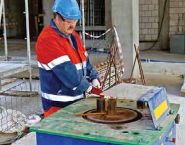
Fot. 15. Środki ochrony oczu oznaczone literą F są wystarczające przy gięciu zbrojenia.
