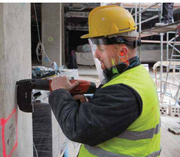
Fot. 17. Przy obsłudze pistoletu do wbijania gwoździ należy stosować osłony twarzy oznaczone literą A .
