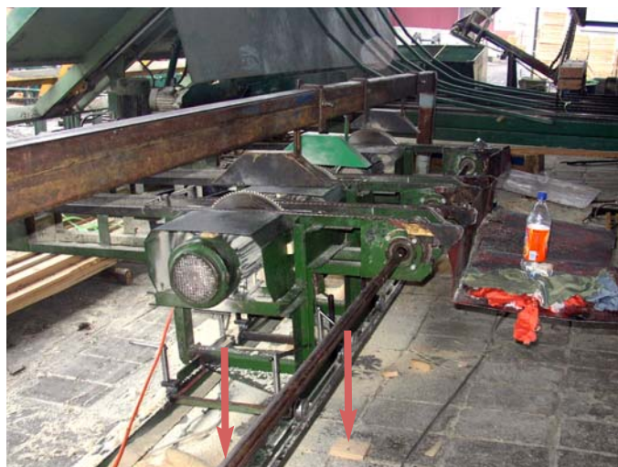
Fot. 2. Pilarka formatująca (pięciopiła) – miejsce wypadku. Strzałkami zaznaczono wałek napędowy i leżące odpady.
