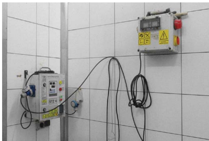
Fot. 5 Zapasowy zasilacz sieciowy na stanowisku ogłuszania.
